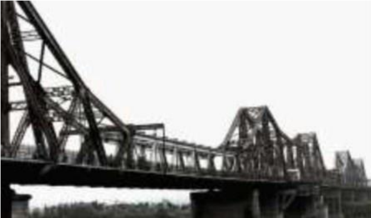
Cầu Long Biên, Gia Lâm–Hà Nội, có chiều dài 1.862 m, cấu trúc 12 đoạn. Xây dựng thời Pháp thuộc vào năm 1890. Ảnh: Huỳnh Tâm.
